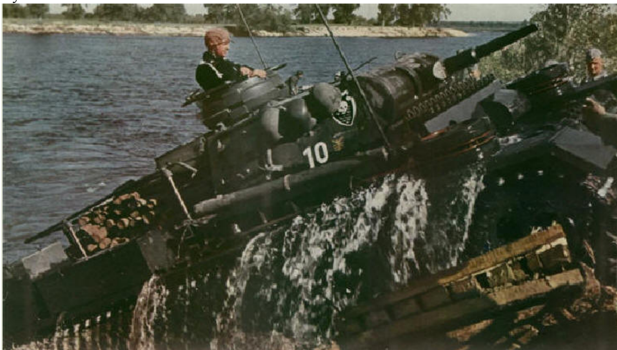
Pz.III из состава 18-й танковой дивизии 47-го моторизованного корпуса танковой группы Гудериана, оснащенный оборудованием подводного движения, форсирует Буг. Что интересно, Днепр таким способом немцы уже не форсировали – ни один из этих танков не дошёл до Смоленска – к 16 июля все они были потеряны в боях.
